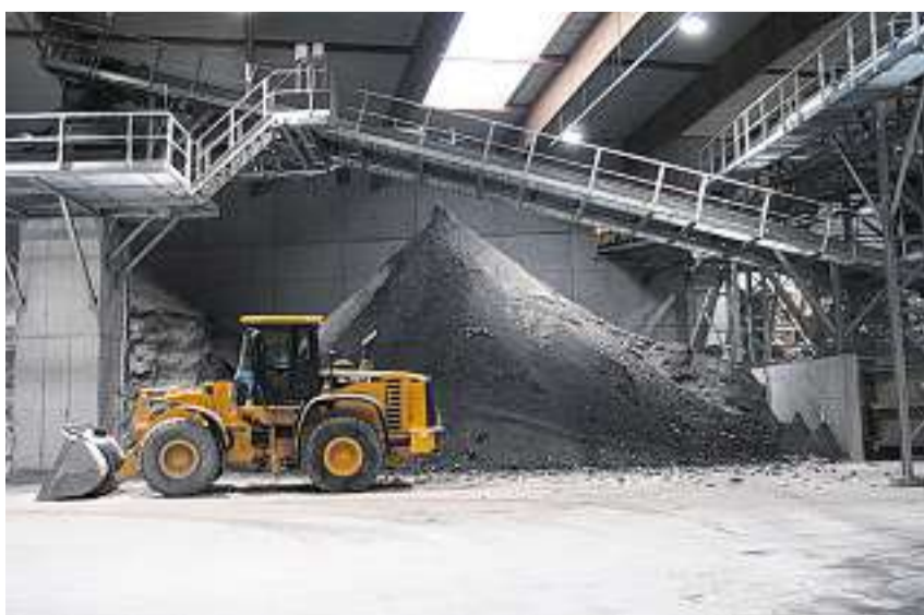
Effizient: Die KVA senkt die Gebühren auch dank einer neuen Anlage.
